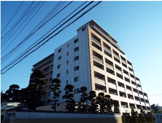
南西方向から見たマンション
