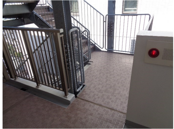
緊急時階段 (改装後)
