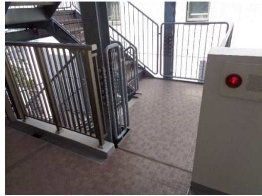
緊急時階段（改装後）
