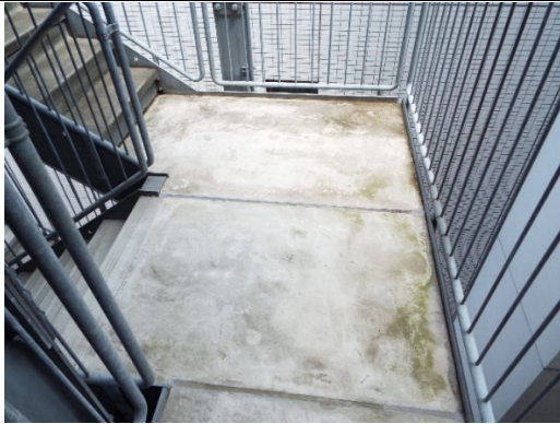
緊急時階段（改装前）
