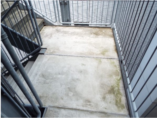
緊急時階段 (改装前)
