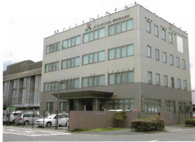
●平成25年 危機管理対応本社社屋建設
