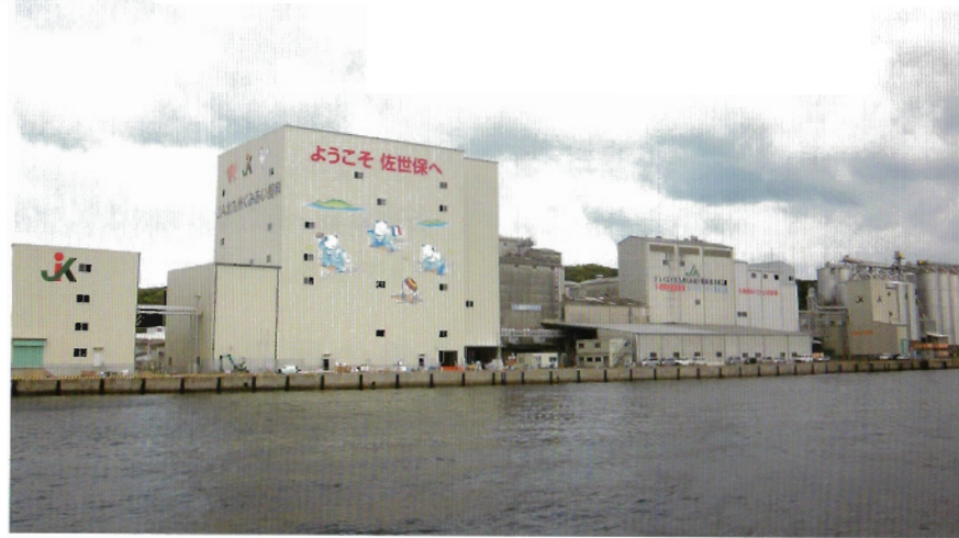
長崎工場全景
