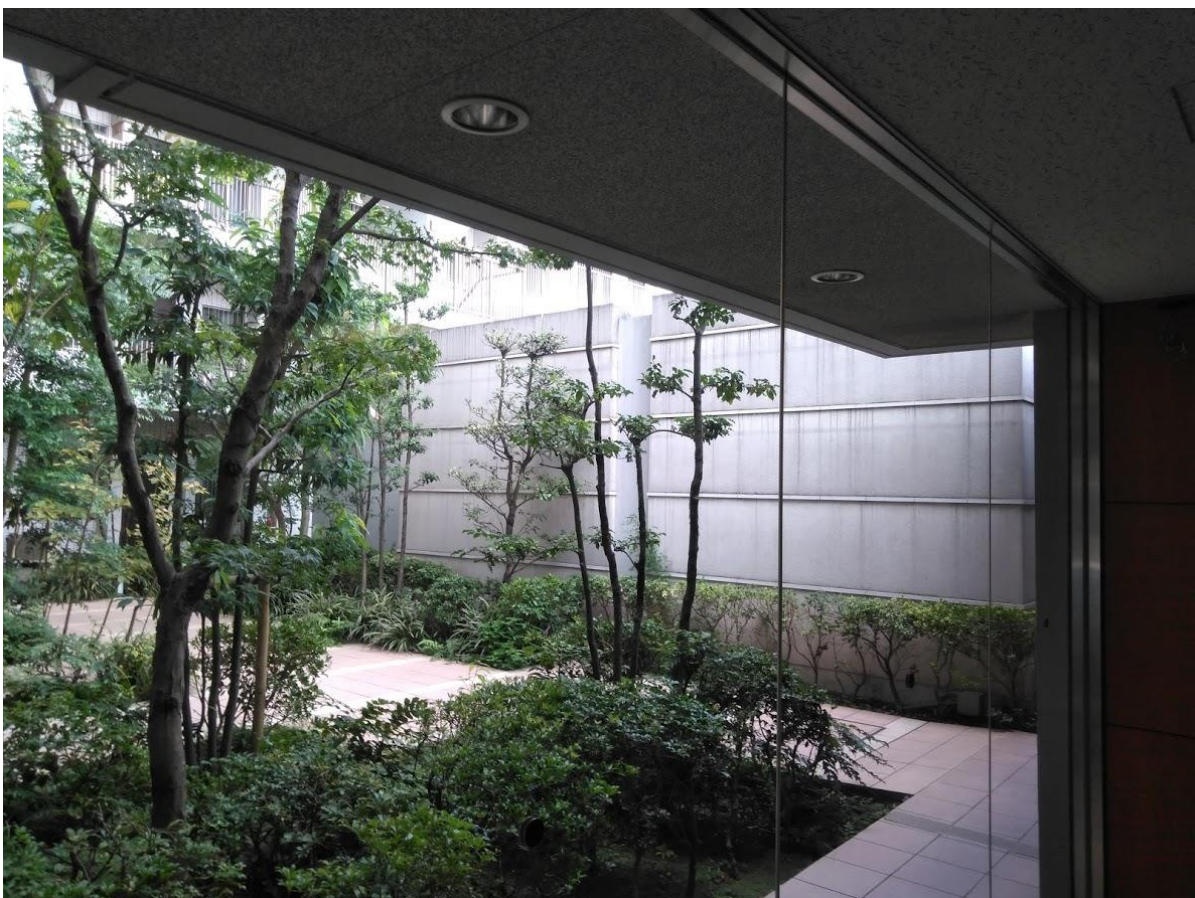
裏通用口への廊下、中庭の電気室外壁の改装、色はどうするか？ これも居住者、特に南棟1～3階の皆さんは日常的に触れ合います。
