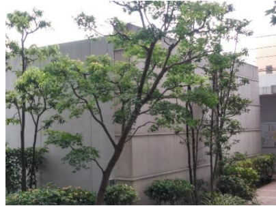
電気室西側と南側壁面
