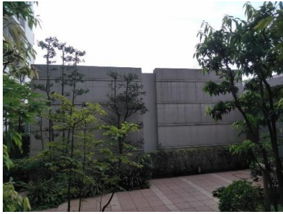
中庭電気室壁面、何色で塗装？
