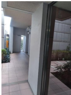
床の汚染対策と柱の汚染
