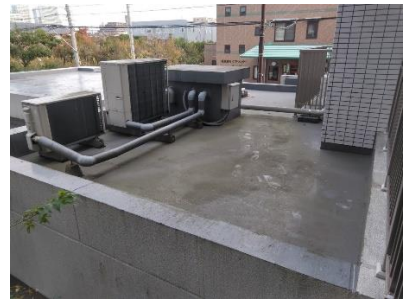
ロビー屋上部分のメンテナンス
