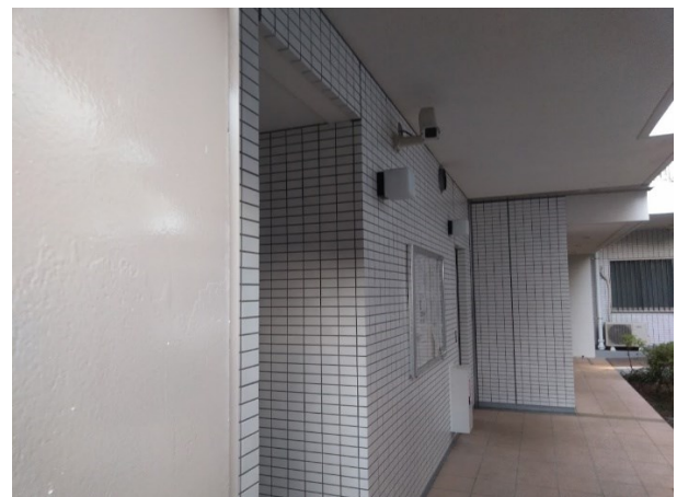
改装後 (タイル貼り)
