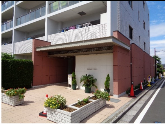
正面（大規模修繕工事で変更）
