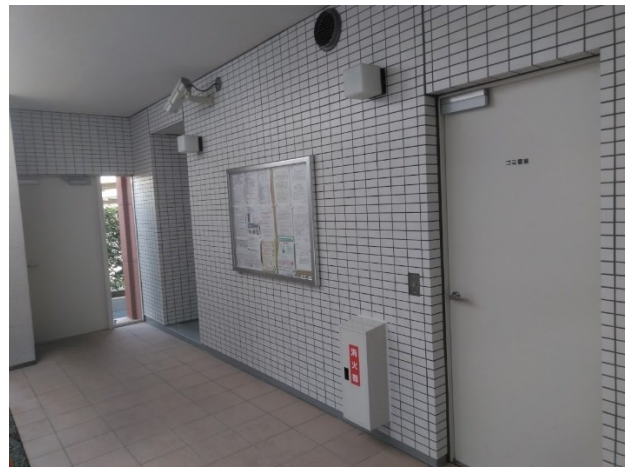
改装後 (タイル貼り)
