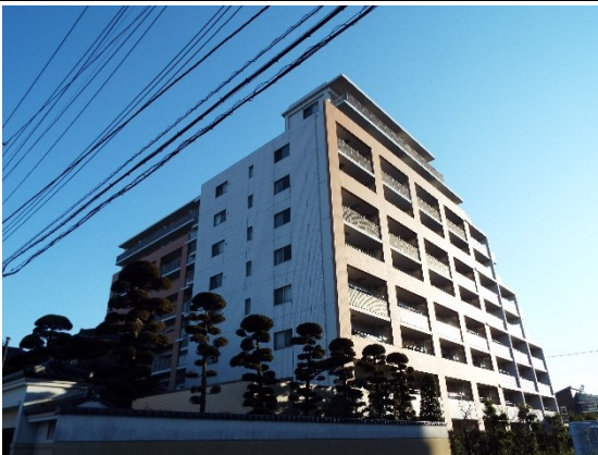
南西方向から見たマンション
