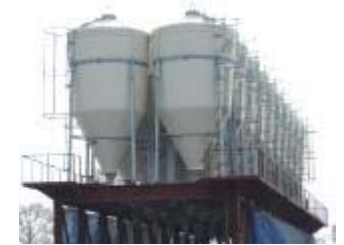
例: TMRセンターに飼料用米保管タンクを増設
