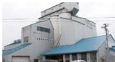
例2: カントリーエレベーターを増築し、飼料用米にも対応
