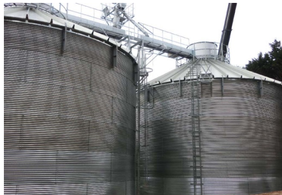
飼料米保管タンク工事中
